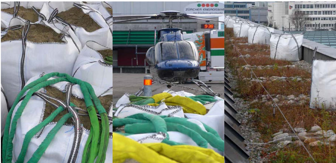
Transport von Sand in Big Bags zur Gestaltung der ökologischen Ausgleichsfläche auf dem Dach der SBB Werkstätte in Zürich
