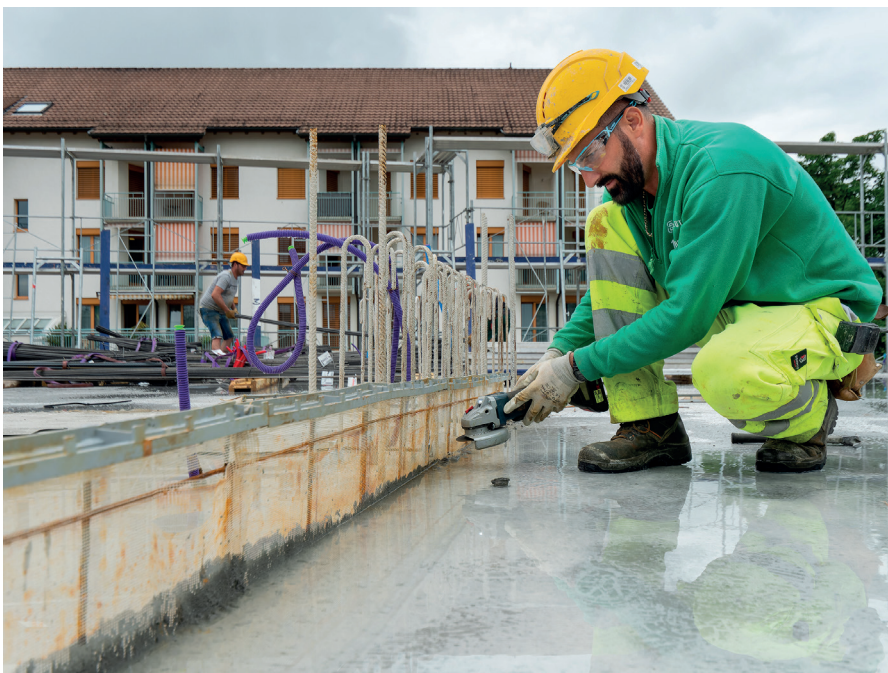
Eine «Super-Truppe» von Bereuter-Mitarbeitenden wirkt auf dem Bauplatz zusammen.
