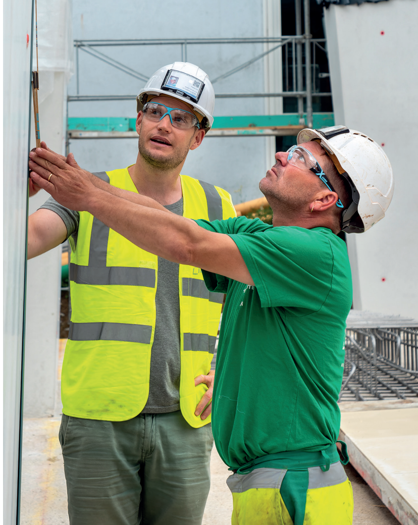
Bauführer Pascal Fluri und Polier Roger Grossenbacher begutachten eine der heiklen trapezförmigen Sichtbeton-Stützen.
