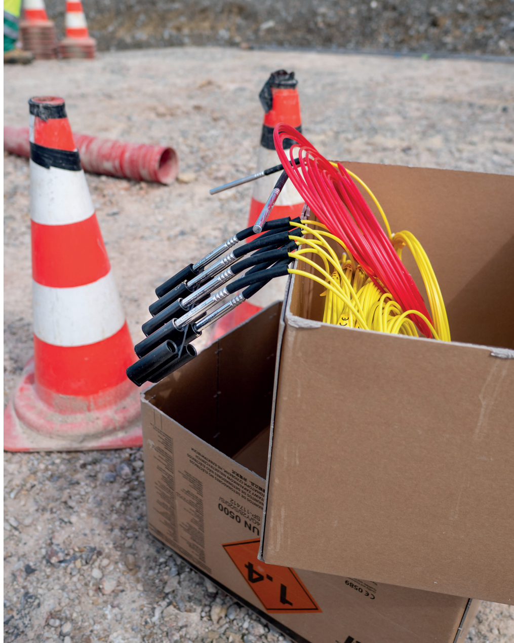
Das Team sprengt pro Jahr rund 115'000 Kubikmeter Fels, verwendet dafür rund 40 Tonnen Sprengstoff und tausende von Zündern.
