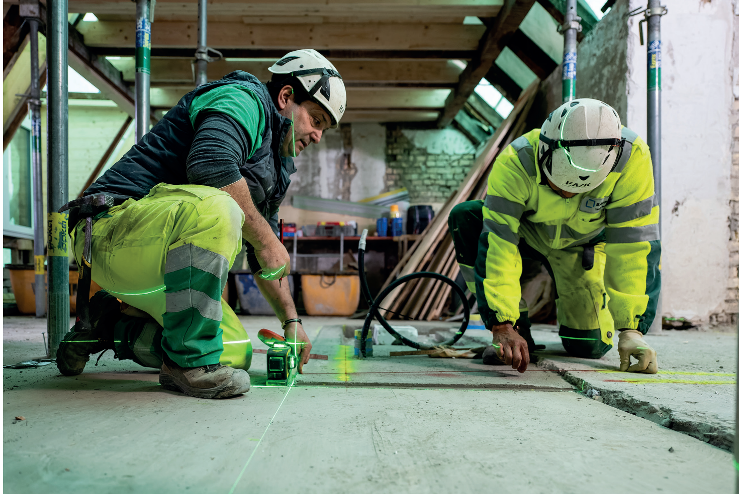
Polier Luis im „Fadenkreuz“: Ausmessen und Anzeichnen für die kommenden Arbeitsschritte.
