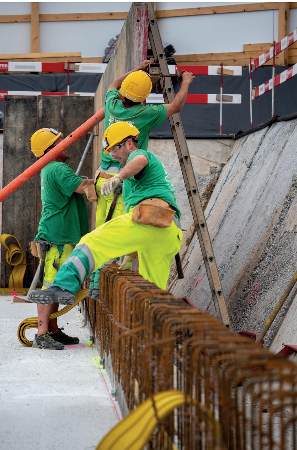
*Die Bodenplatte der künftigen Tiefgarage ist betoniert. Die ersten Wände folgen.*
