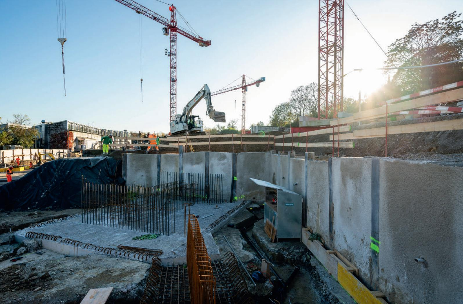
Mehrere Rühlwandabschnitte mit gesamthaft 160 Trägern sichern die weittläufige Grube.
