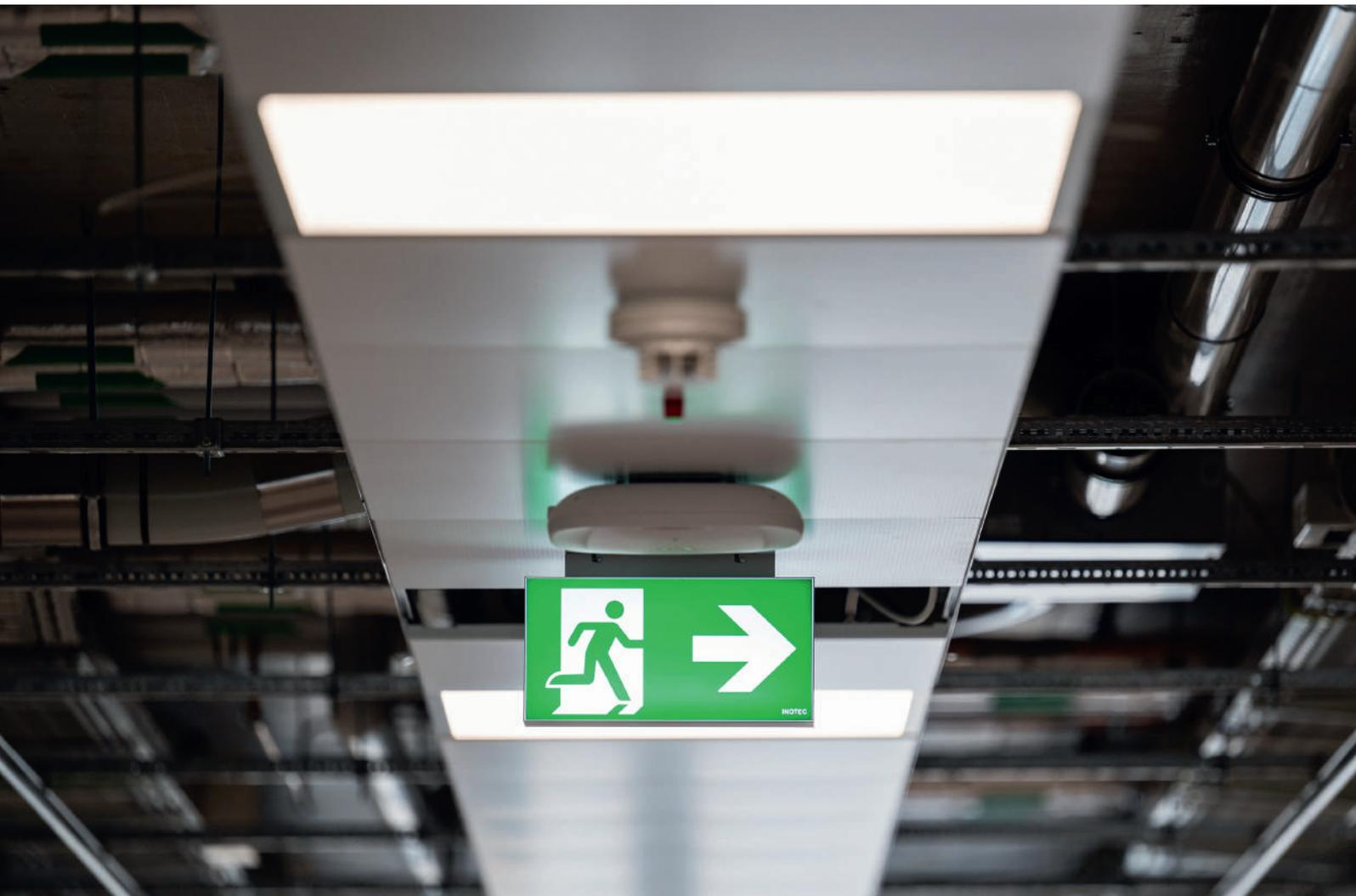
*Beim Integralen Gebäudevortest wurde das Zusammenspiel von Brandmeldeanlage und Gebäudetechnik geprüft.*
