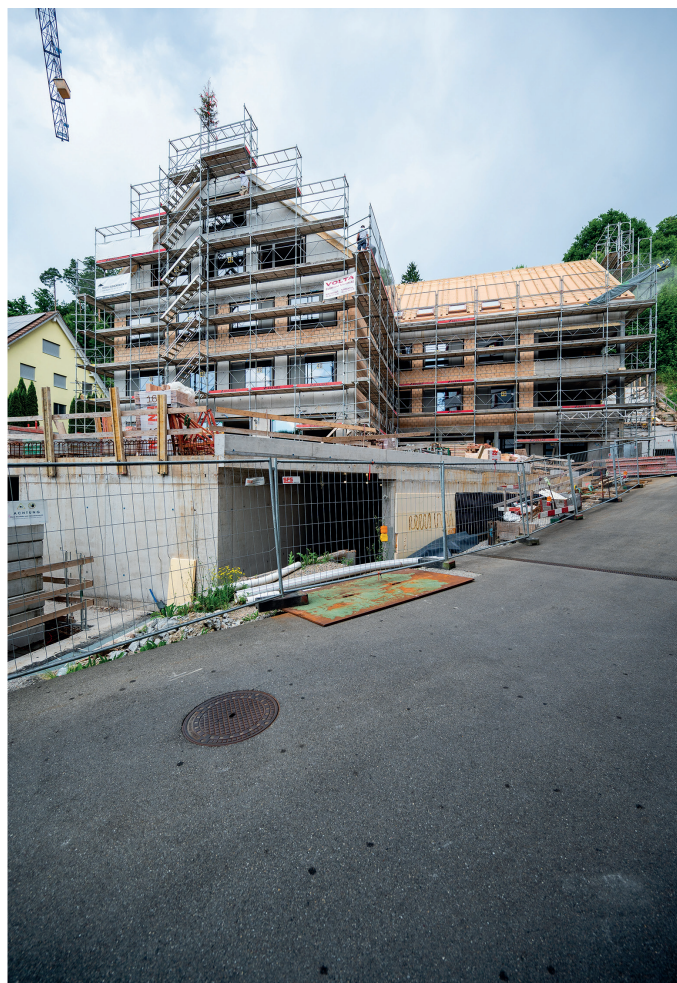
Die geneigten Betonflächen im ersten Dachgeschoss waren herausfordernd beim Schalen sowie Betonieren.
