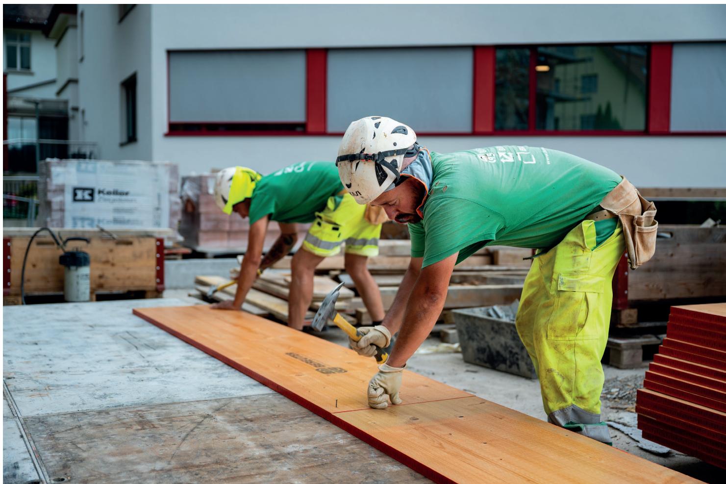
Mitarbeiter der Bereuter Bau AG bereiten die Schalung für eine Stützmauer hinter dem Erweiterungsbau vor.
