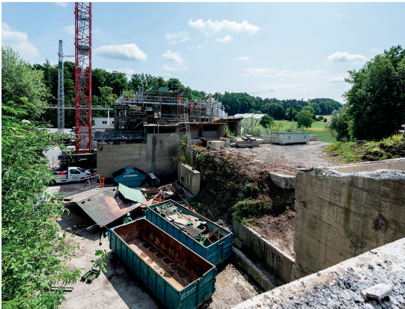
Auf dem ehemaligen Waschplatz wird das Material sortiert und zerlegt. Funktionsfähige Anlagenteile werden verkauft.
