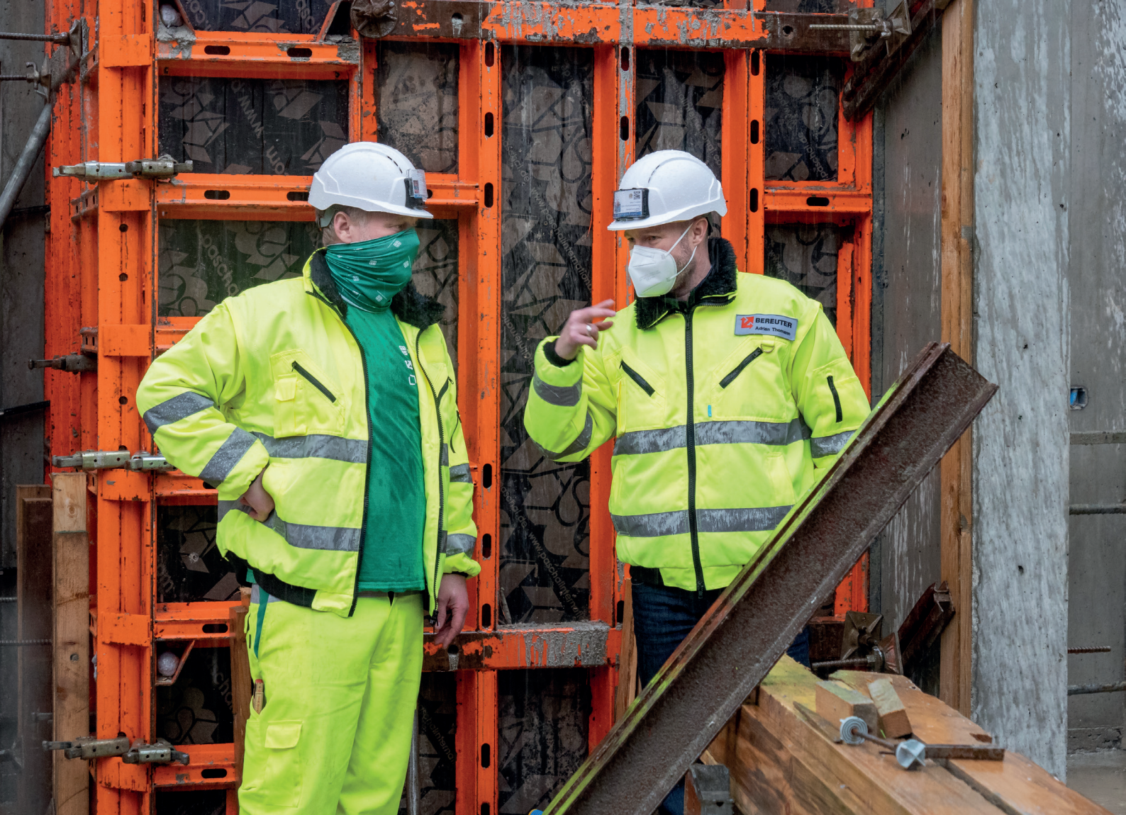
Adrian Thomann (rechts) fachsimpelt mit Polier André Rügsegger über Beton, Mauersteine und Verzögerungen.
