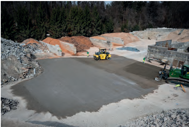
In einem Samstagseinsatz baute eine Gruppe von BEAG- und BGT-Mitarbeitenden den Walzbeton ein.
