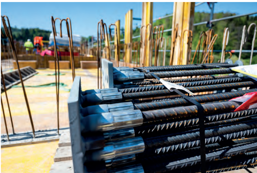
Die neue Halle wird über eine Passerelle mit einem bestehenden Gebäude verbunden. Eindrückliche Armierungsanschlüsse schaffen die Grundlage dafür.
