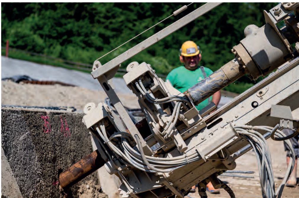
«So eine Geologie habe ich noch nicht erlebt», sagt Bauführer und Kalkulator Markus Vanoni (Bild oben).
