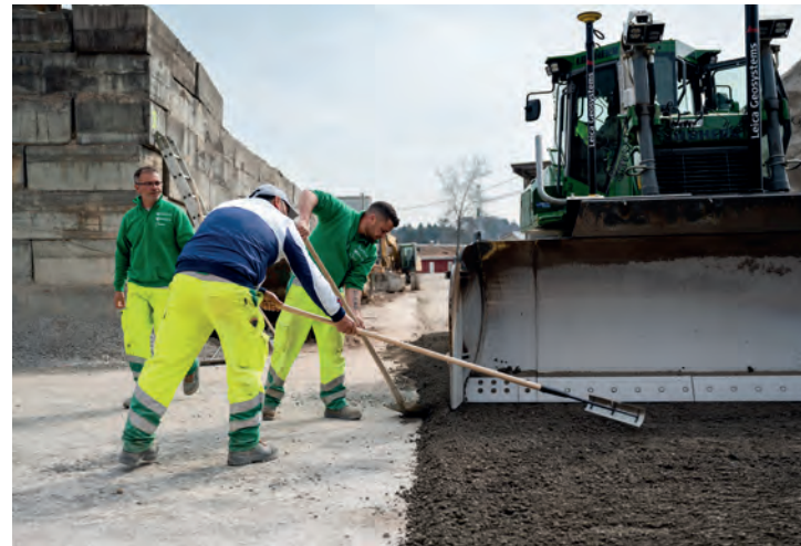
In einem Samstagseinsatz baute eine Gruppe von BEAG- und BGT-Mitarbeitenden den Walzbeton ein.
