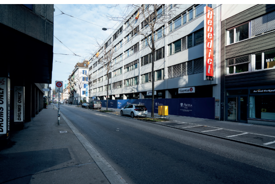
In das ehemalige Sprach-«Schulhaus» werden 160 Micro-Zimmer und -Wohnungen eingebaut.
