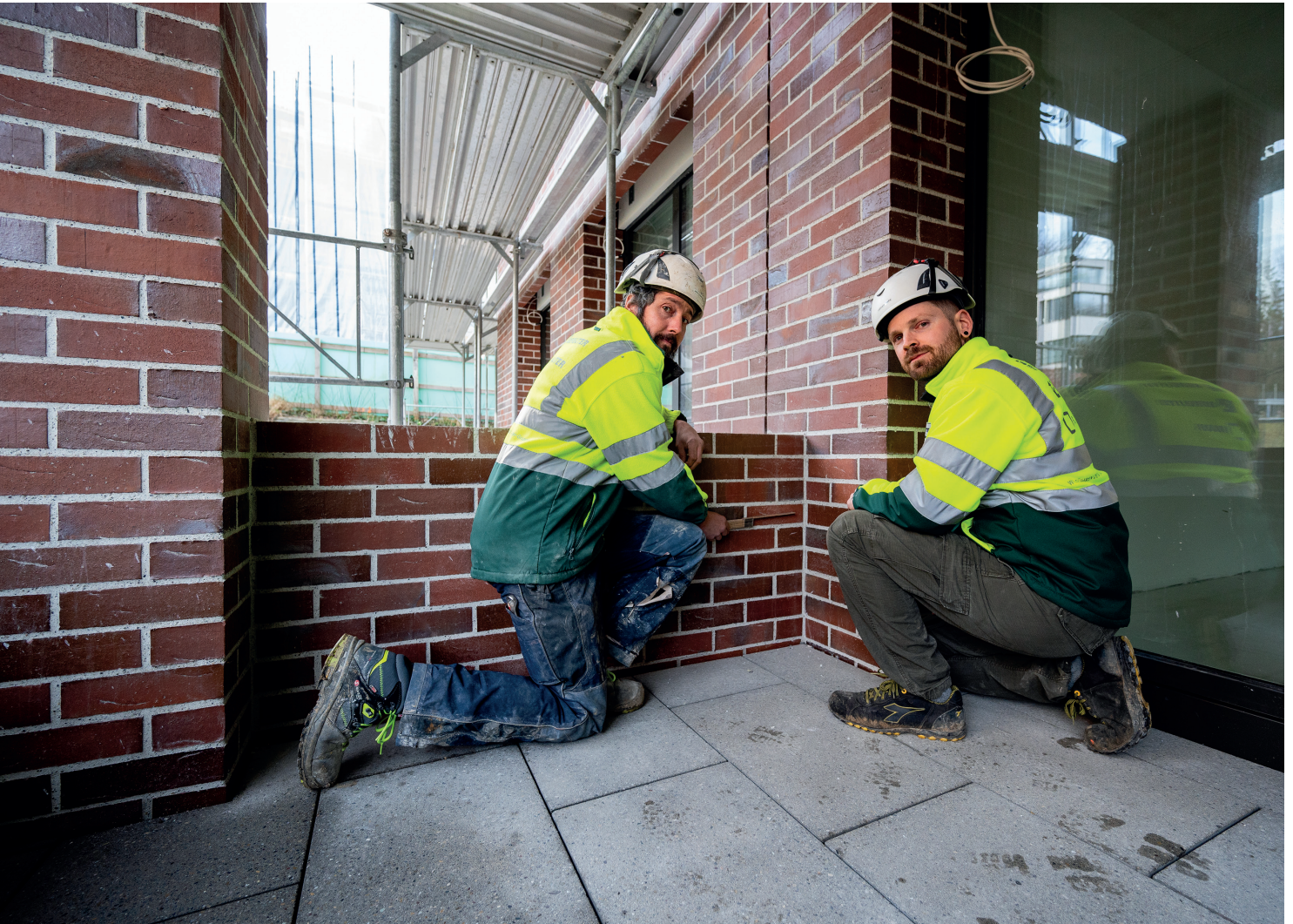
Bauführer Micha Lattmann (rechts) und Vorarbeiter Robert Jehle begutachten zusammen einen Balkonabschnitt der komplexen Fassade.
