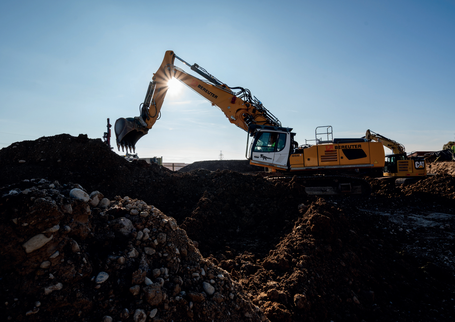
Maschinist Jeton Jakupi hat mit seinem Bagger alles im Griff - und die Sonne im Gesicht.
